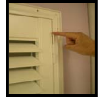
Insert Hinge Pin
